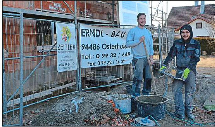
Selbst im Winter wird in Osterhofen am Bau gearbeitet: Sebastian Erndl (l.), angehender Meister, und Lehrling Ibrahim Mohamed mischen den Mörtel zum Verputzen der Inneninstallationen an.
